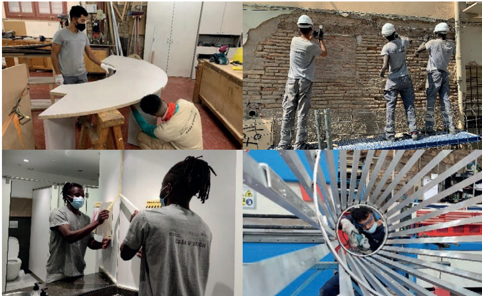
Treballs de paleta, pintura, fusteria i soldadura
